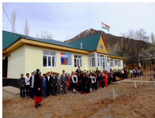
Школьники на линейке около новой школы №3. На правой стороне, на фасаде висит информационная доска об успешной реализации проекта
